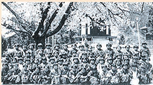
奉安殿：写真の後に写る建物。 教育勅語等が安置されていた。
